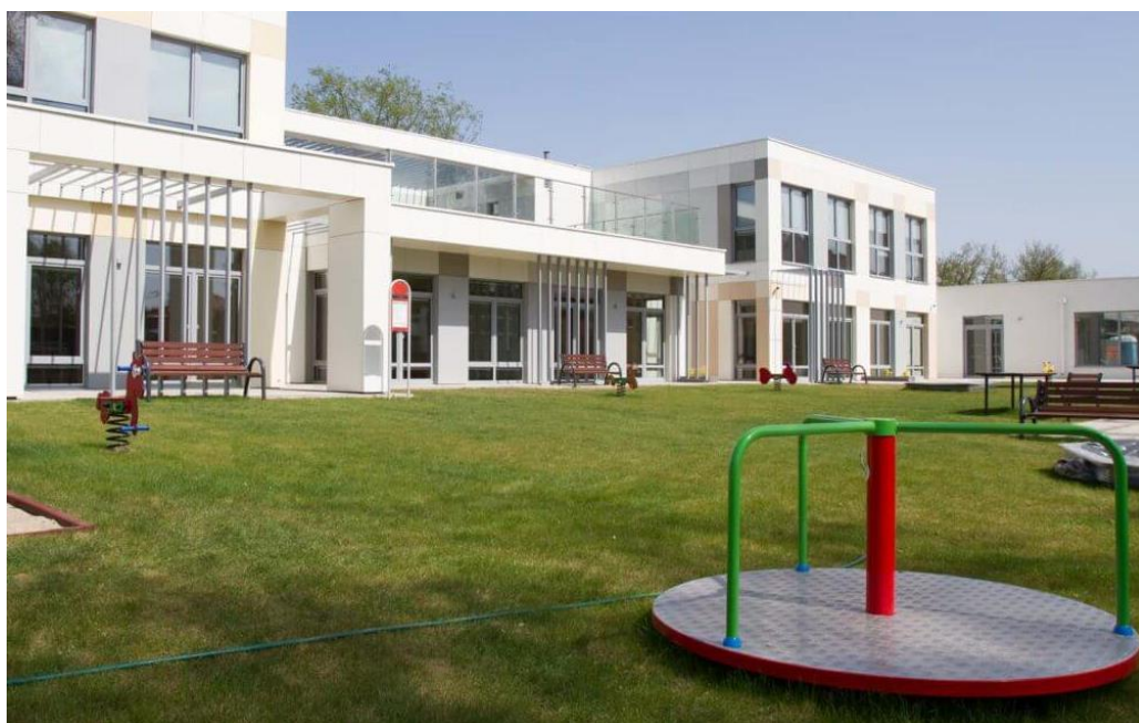
Fot. 21 Przedszkole Miejskie Nr 2 przy ul. Dużej
