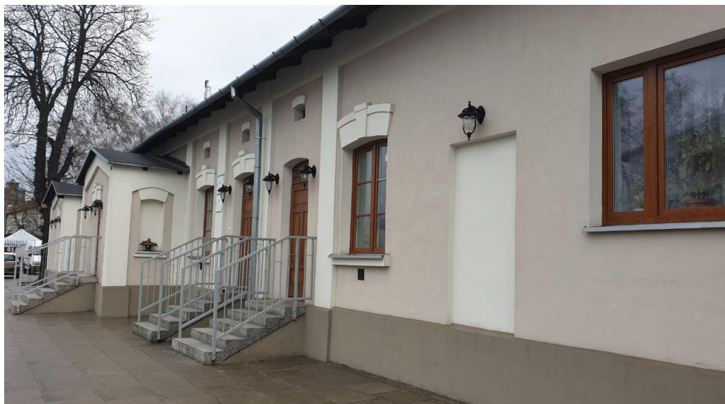
Fot. 18 Kamienica przy Al. Piłsudskiego
