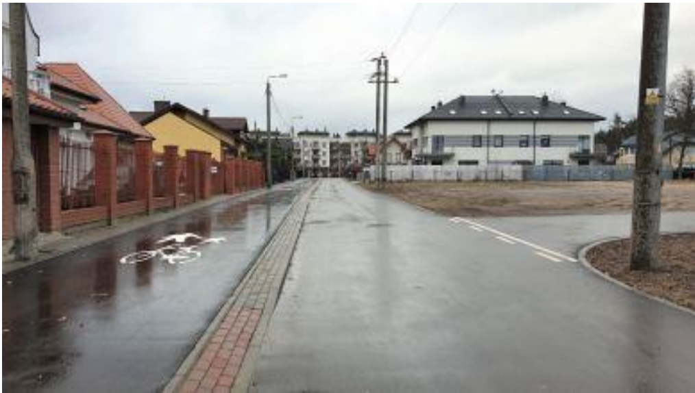
Fot. 12 Przebudowana ulica Mokra
