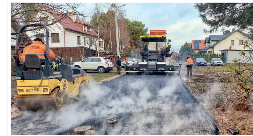
Układanie asfaltu w ulicy Żółkiewskiego.
